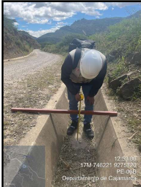
Figura 9. Presencia de cunetas en el primer tramo (0+010.00KM).
