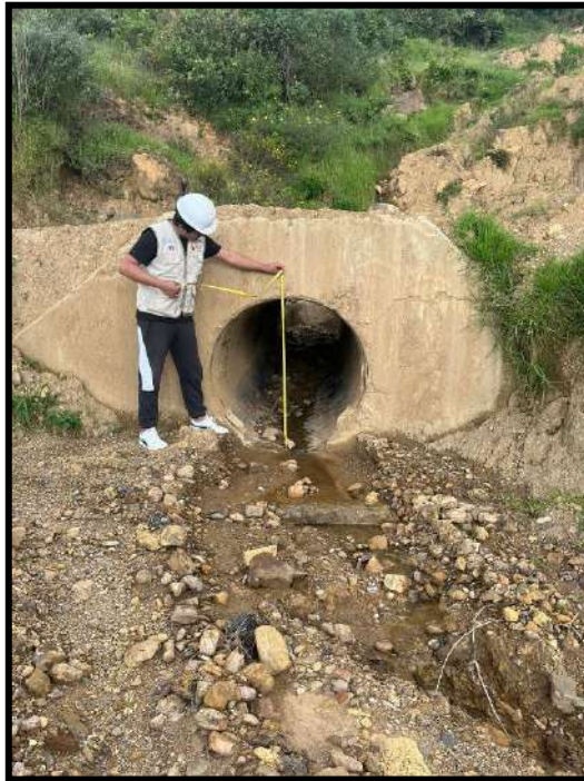
Figura 5. Alcantarillas existentes.
