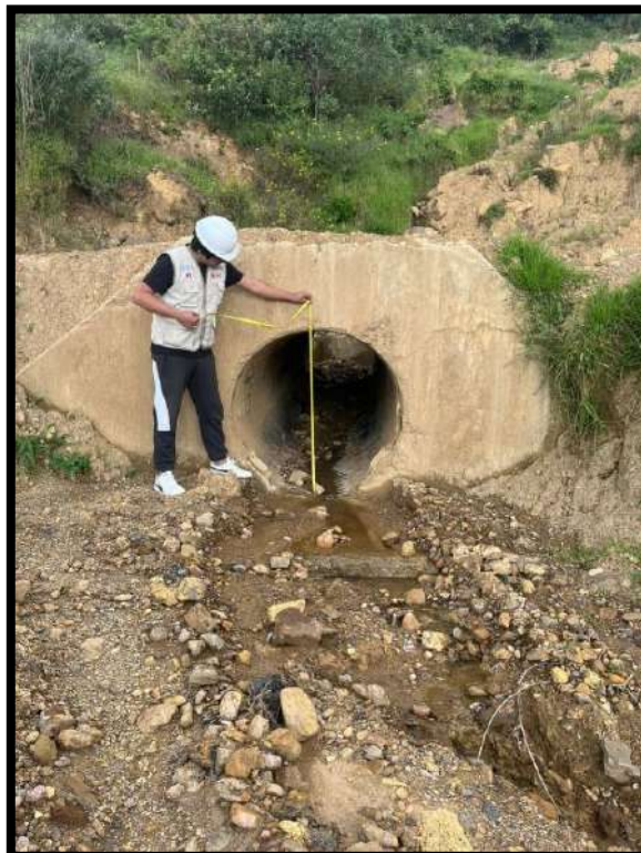
Figura 10. Presencia de alcantarilla en el tramo (3281.73km).
