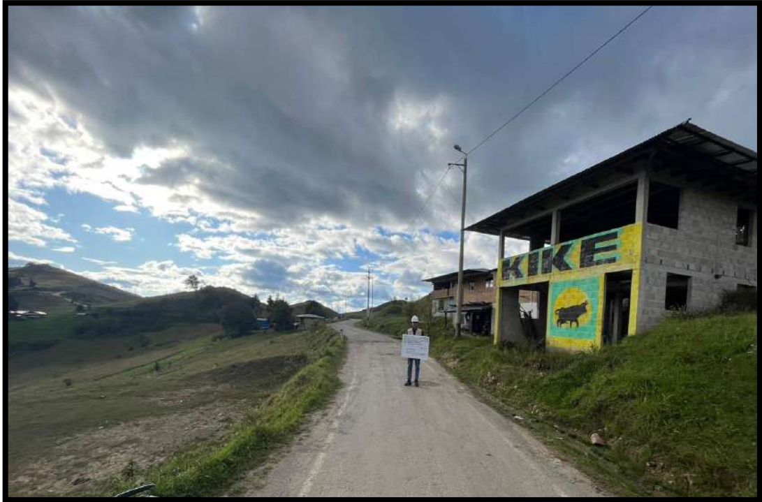
Figura 3. Predio Afectado en el Km 7+100.00.
