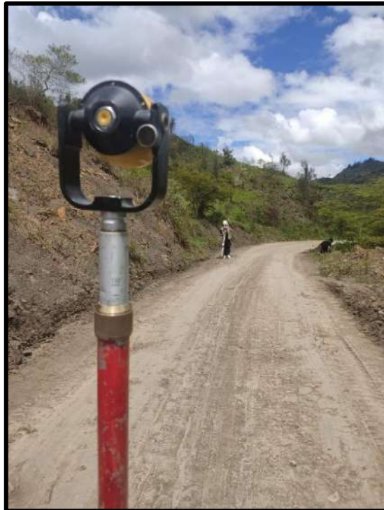
Figura 1. Inicio del levantamiento topográfico.
