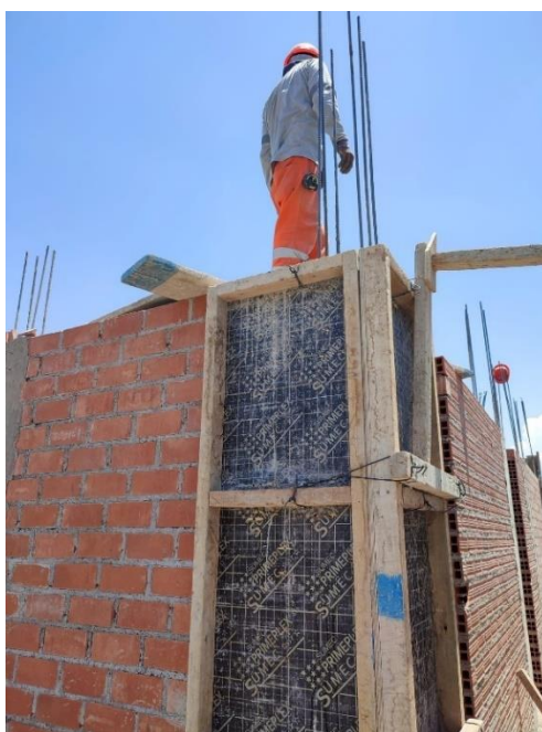
Figura 25. Encofrado de columnas
