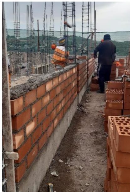
Figura 36. Levantamiento de muro
