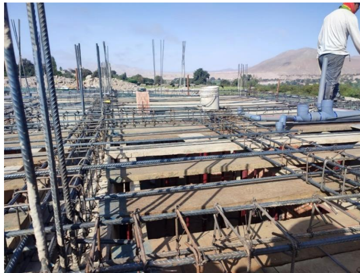
Figura 32. Acero en losa aligerada
