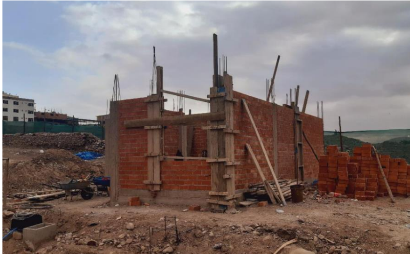
Figura 23. Vaciado de columnas
