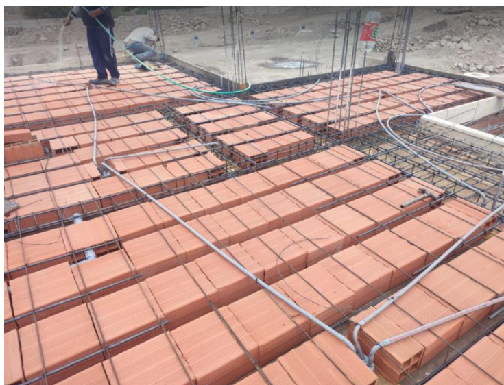
Figura 34. Colocación de ladrillos de techo
