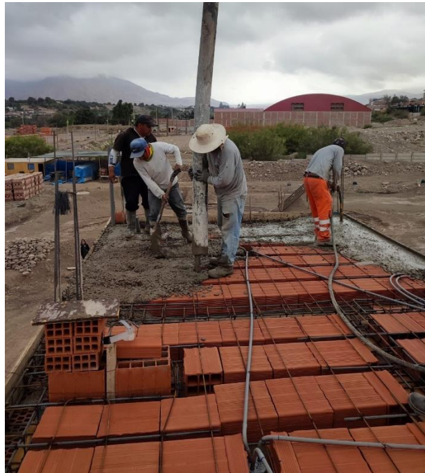
Figura 28. Colocación de concreto en losa aligerada
