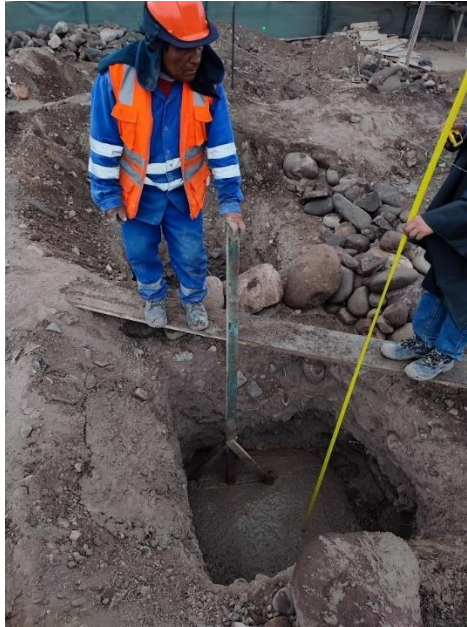
Figura 18. Vaciado de solados
