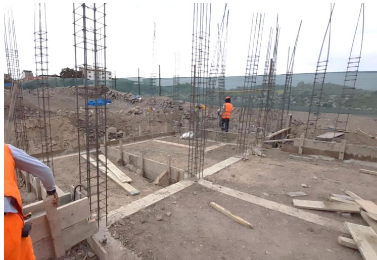
Figura 16. Colocación de cimiento corrido
