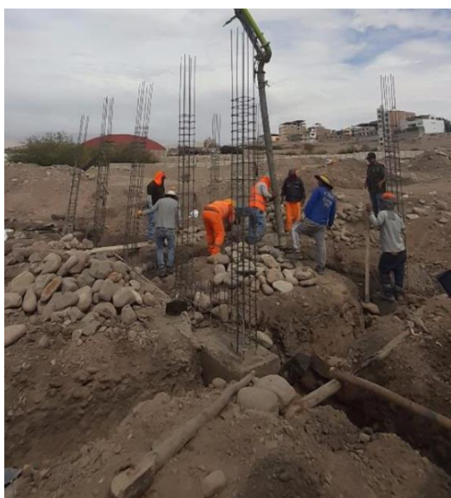
Figura 20. Vaciado de zapatas
