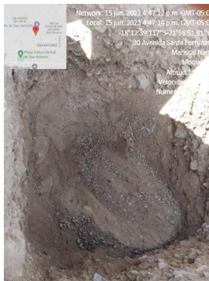
Figura 9. Calicata 02 en la Avenida Santa Fortunata progresiva. 0+670
