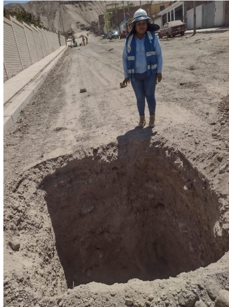
Figura 8. Calicata 01 en la Avenida Santa Fortunata progresiva. 0+170
