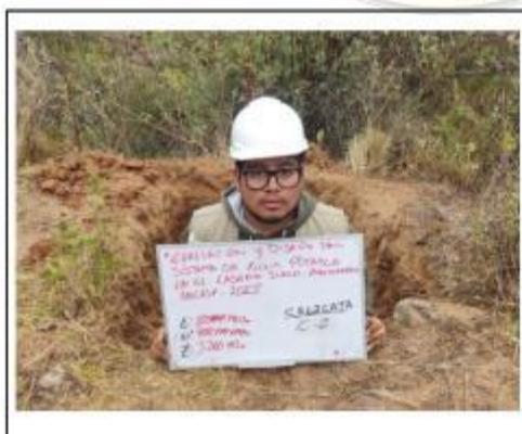
FOTO 02: SE OBSERVA LA EXCAVACIÓN CALICATA C-02.
