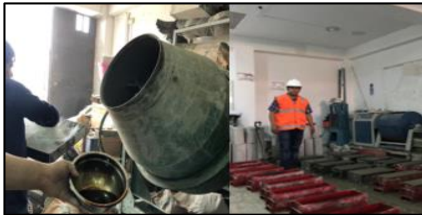
Fotografía 5. Elaboración del concreto y vaceado de vigas y probetas
