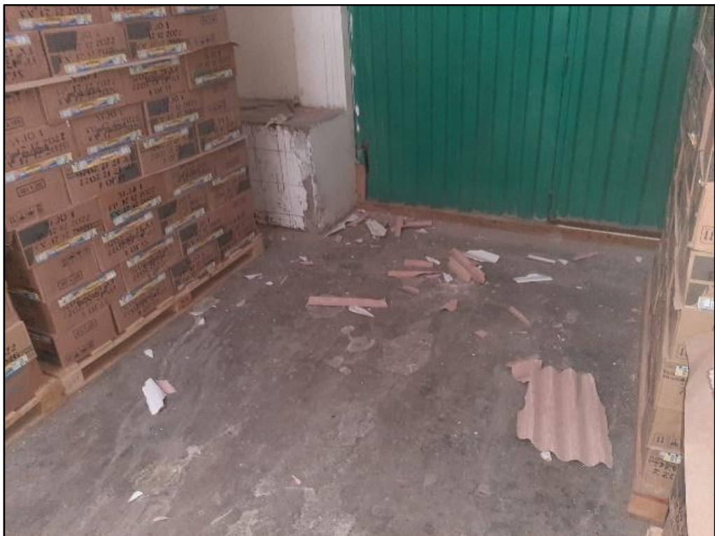
Figura 9 Almacén de producto terminado de la empresa Corporación Pesquera Apolo S.A.C.
