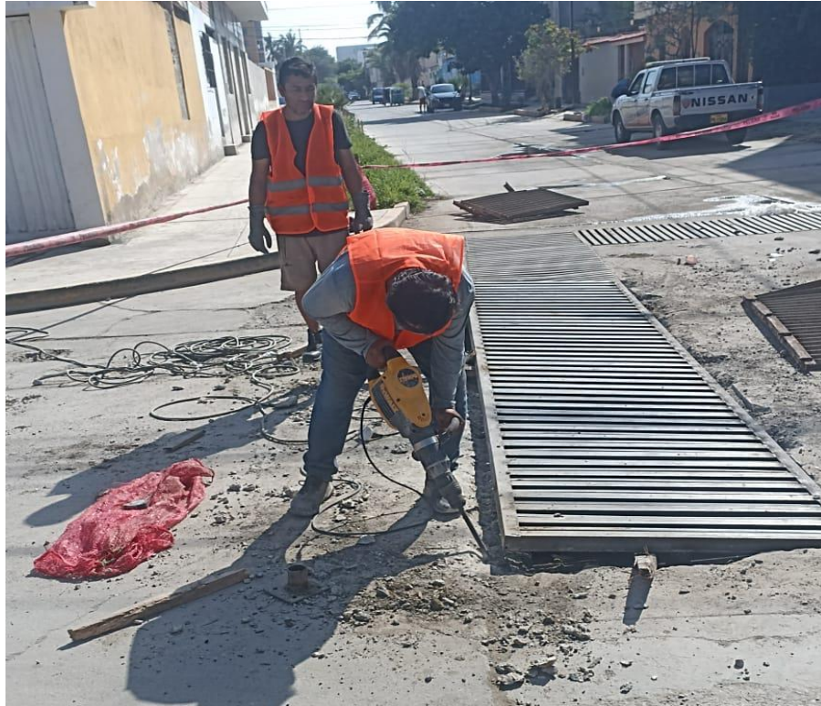
Anexo 7.6 “Obra reparación de la rejilla en El Chilcal”
