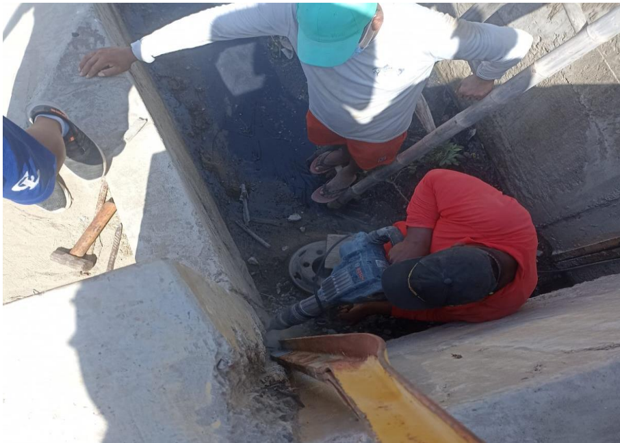
Anexo 7.9 “Obra reparación de la compuerta en La Granja de Colores”
