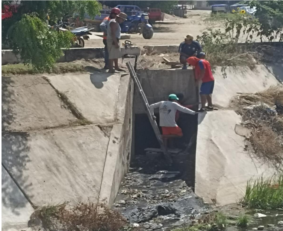
Anexo 7.8 “Obra reparación de la compuerta en La Granja de Colores”
