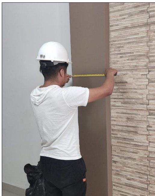
Figura 3 Toma de datos de columna
