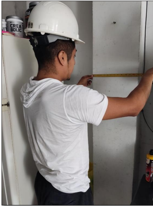
Figura 4 Toma de datos de una columna
