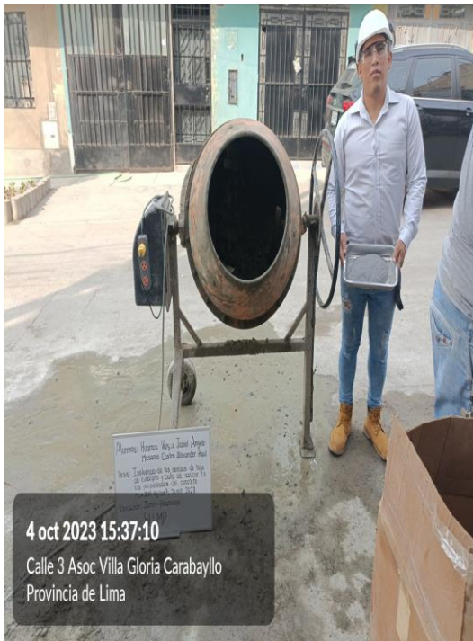
VACIADO DE CONCRETO CAÑA DE AZÚCAR
