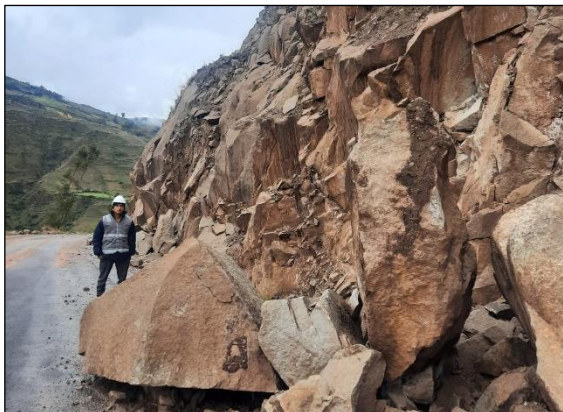
Fotografía 1: Identificación de taludes rocosos
