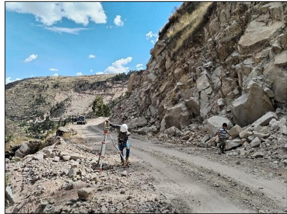
Fotografía 6: Levantamiento topográfico del talud rocoso 3
