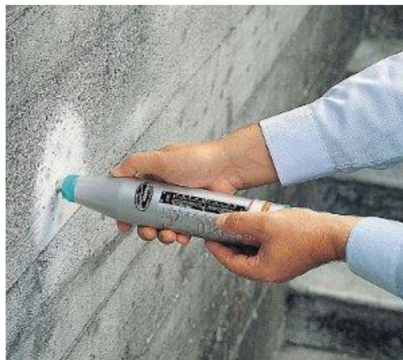
Figura 2. Ensayo de esclerometría
