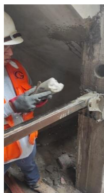
Figura 18. Extracción de la porción de concreto
