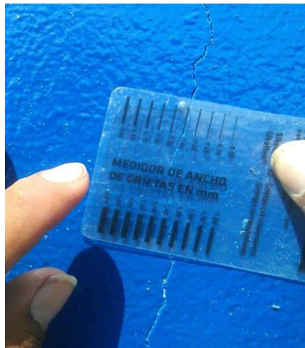
Figura 3. Medidor de ancho de grieta
