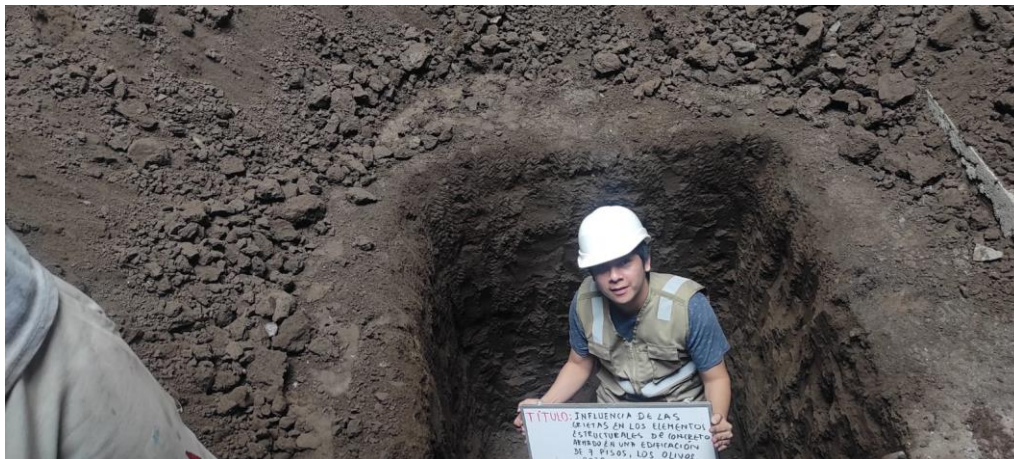
Figura 31. Profundidad de la calicata
