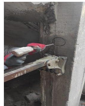
Figura 17. Inicio de la extracción del bloque de concreto
