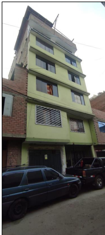
Figura 35. La edificación de 7 niveles
