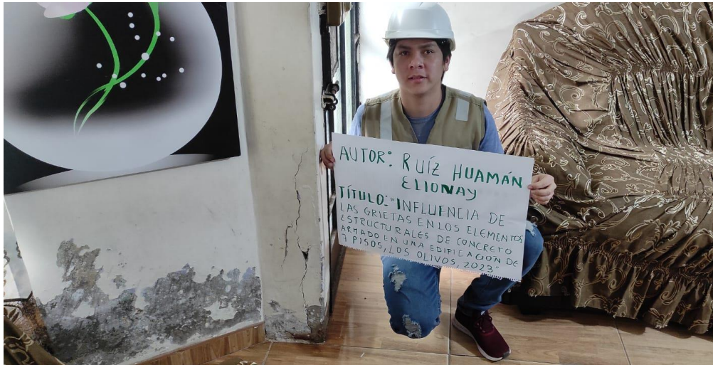
Figura 10. Inspección visual realizada en la edificación estudiada
