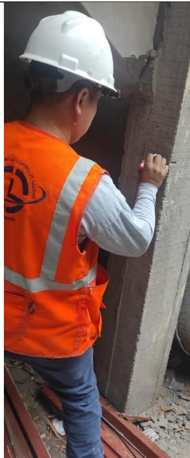
Figura 13. Identificación del punto para realizar el ensayo
