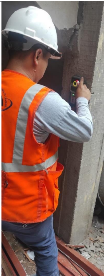
Figura 12. Detector del acero para no ser perforado
