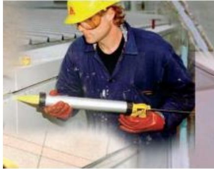
Figura 49. Pistola para inyección en grietas
