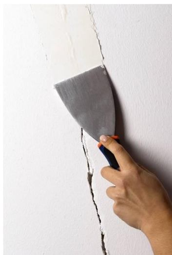
Figura 50. Reparación de grieta
