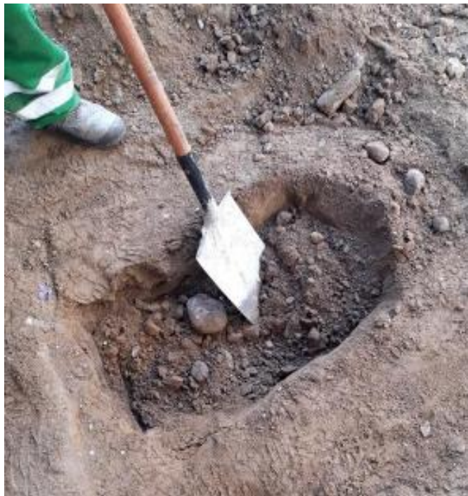
Figura 12. Excavación de calicata C-2.
