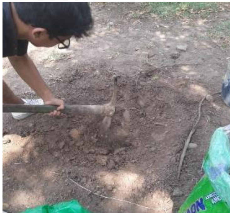
Figura 8. Excavación de calicata C-1.
