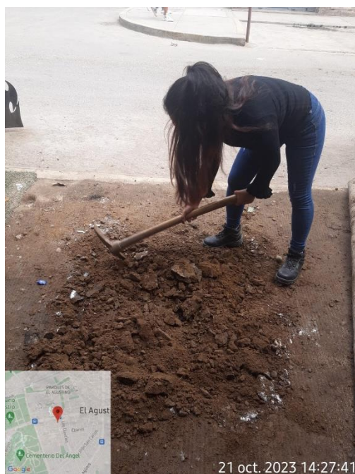
Excavación de calicatas C-1, C-2, C-3
