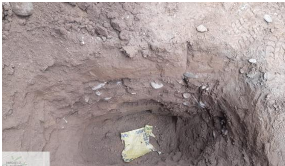
Figura 16. Excavación de calicata C-3.
