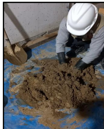
Fotografía 6. Amasado de los agregados
