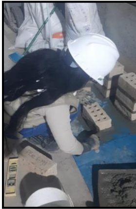
Fotografía 1. Colocación de ladrillos para pila
