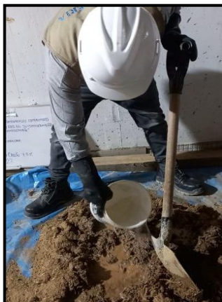
Fotografía 5. Amasado de los agregados.
