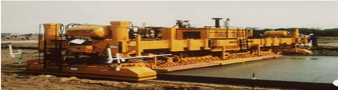
*Figura 2.* Construcción del pavimento rígido
