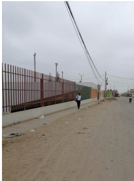
Figura 25: Situación actual referente a la escasez de vegetación en las áreas destinadas a espacios verdes en la Calle Ramón Castilla.
