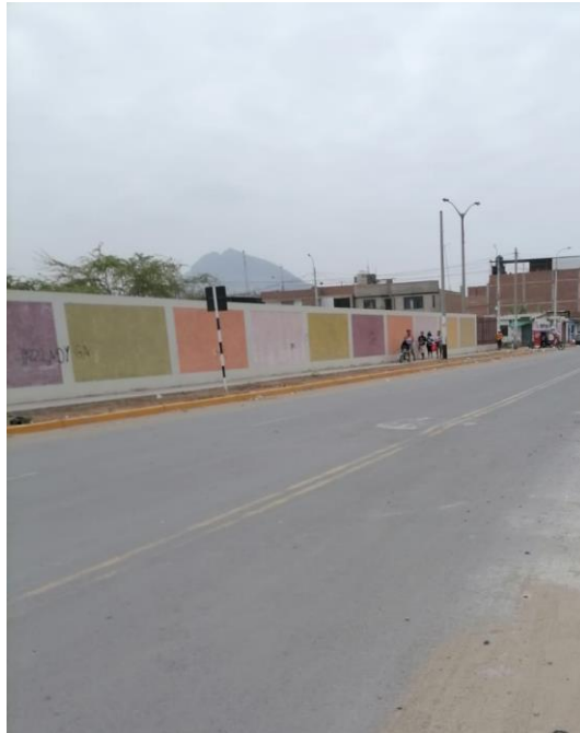
Figura 28: Situación actual referente al estado de conservación de pista en la Av. Haya de la Torre.
