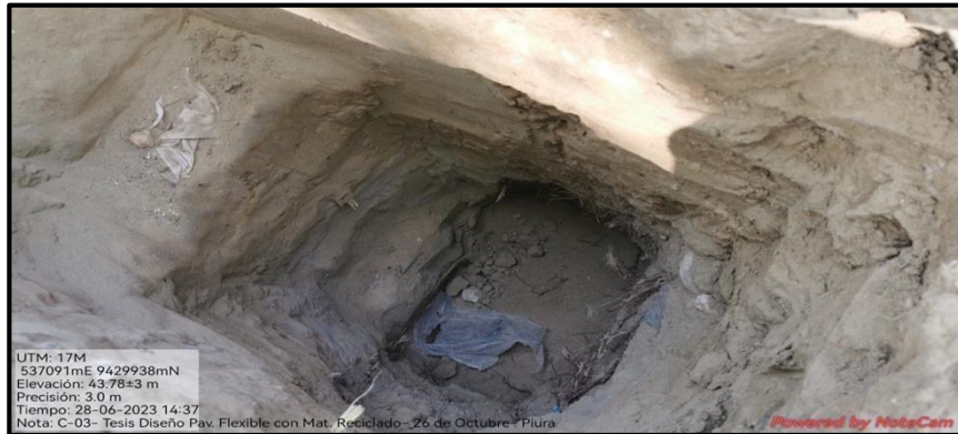
Figura N° 46. Excavación de la calicata 03
