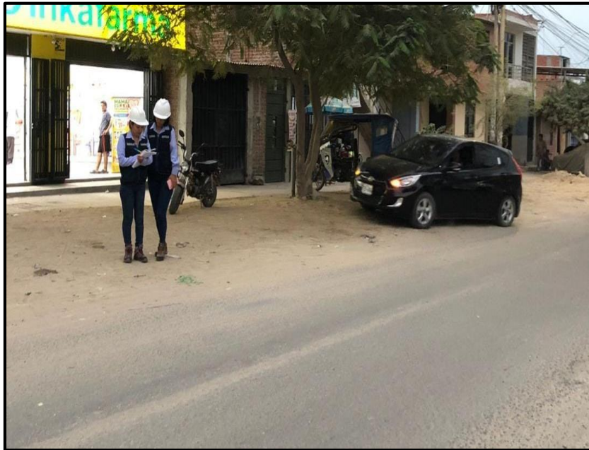
Figura N° 33. Conteo Vehicular de la Avenida los Algarrobos.
