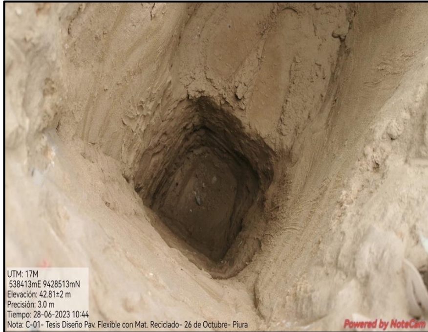
Figura N° 38. Excavación de la primera calicata 01.
