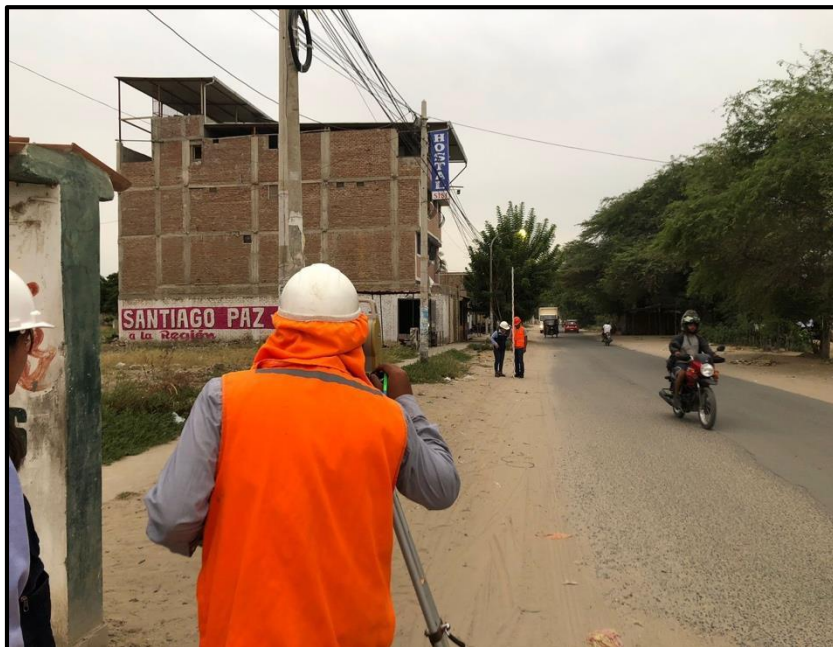
Figura N° 34. Topografía en el punto de inicio de la Av. Algarrobos
