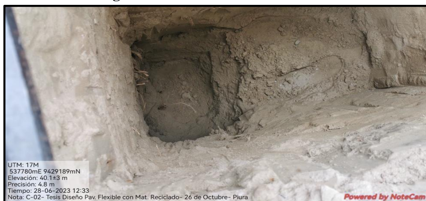
Figura N° 42. Excavación de la calicata 02
