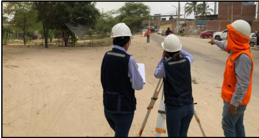
Figura N° 36. Topografía en la progresiva 0+ 600 de la Avenida los Algarrobos.
