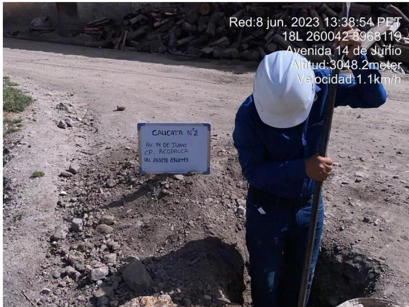
Figura 3: excavación de calicata.
