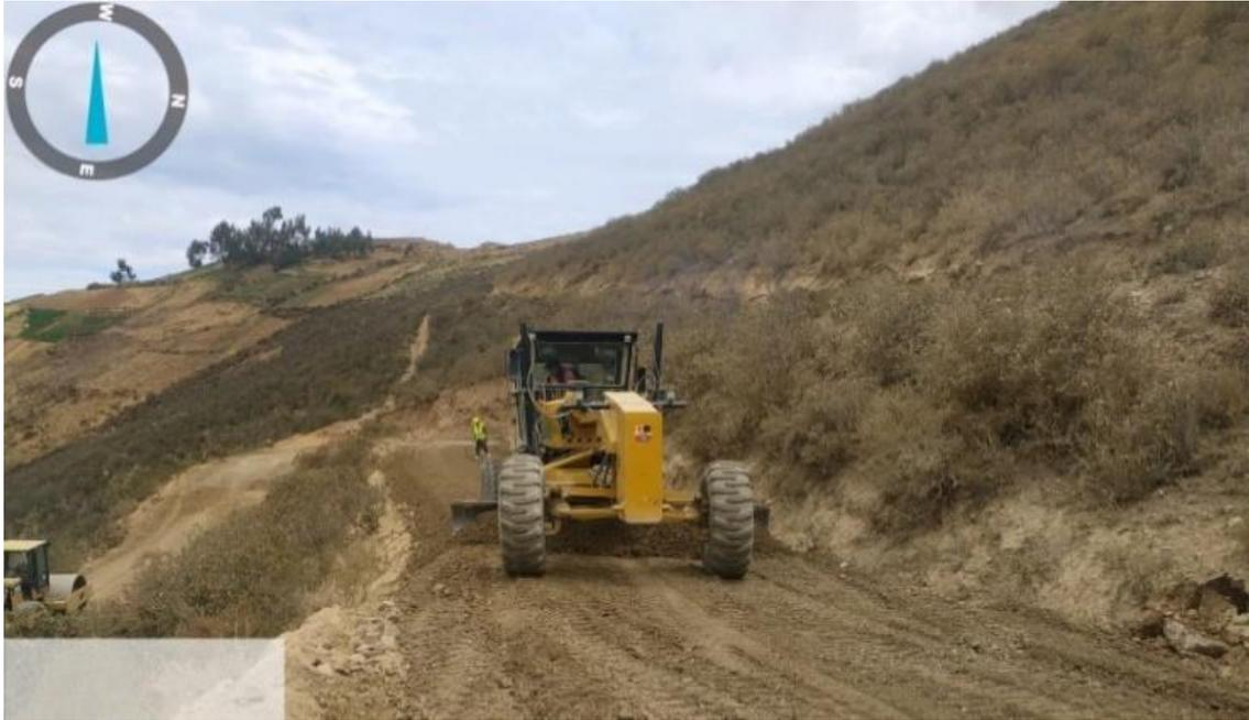
Figura 2: Suelo estabilizado con material de préstamo.
