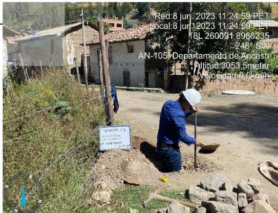
Figura 3. Excavación de las calicatas con una profundidad de 1.50 metros
