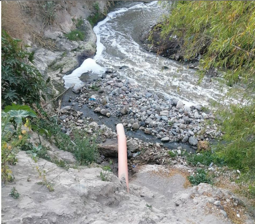
Foto N° 03. Desfogue de aguas servidas de viviendas aledañas al río Alameda
