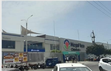
Se observa la fachada frontal y lateral izquierda que colinda con la A.V Pardo y el mercado La Perla
