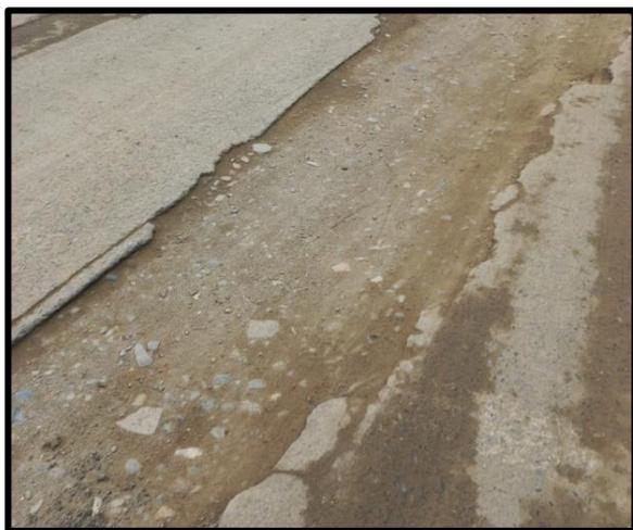
Figura 1. Presencia de Fisuras.
