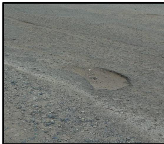
Figura 2. Hundimientos de superficie
