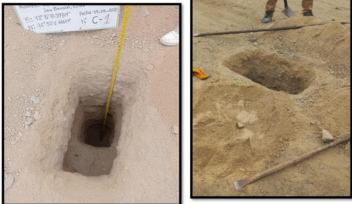
**Figura 2.** Realización de las calicatas de una profundidad e 1.50 m.
