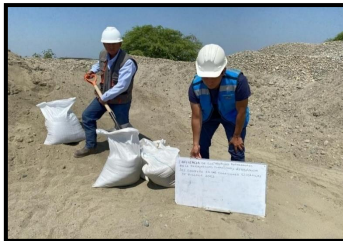
Figura 8. Extracción de agregado fino - cantera Santa Cruz
