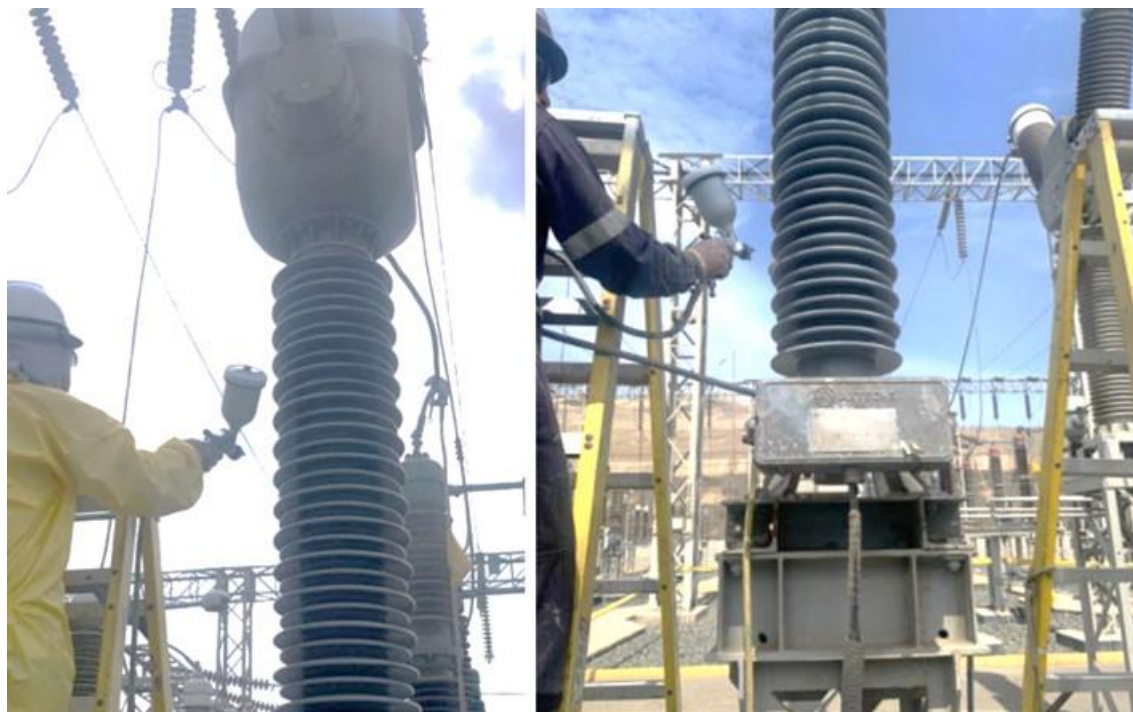
Figura 40 Aplicación de goma silicona sobre Transformadores de corriente TC-4013 y 4014
