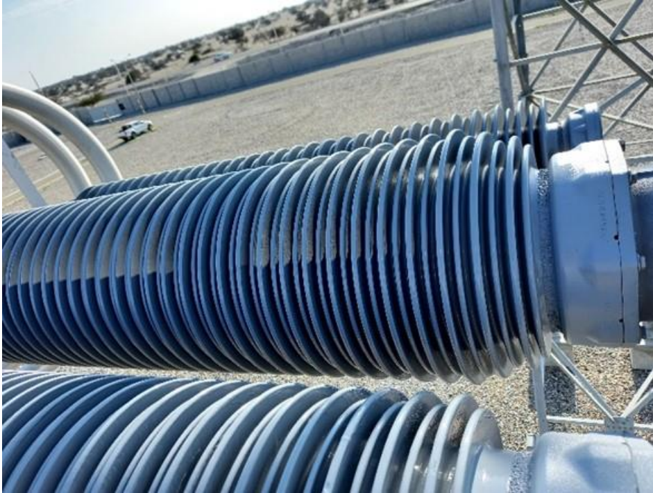
Figura 47 Recubrimiento total de goma RTV sobre IN-5162
