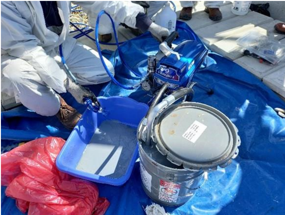
Figura 43 Conexiones de compresor a pintura y equipo a pintar Fuente: Subestación eléctrica la Niña 500 kV interruptor IN-5162
