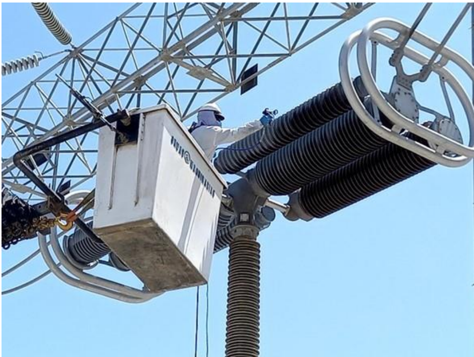
Figura 46 Proceso de aplicación del recubrimiento de la silicona RTV Fuente: Subestación eléctrica la Niña 500 kV interruptor IN-5162
