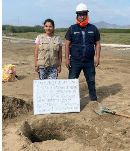
Figura 2. Excavación de calicatas en la Vía Playa Atahualpa
