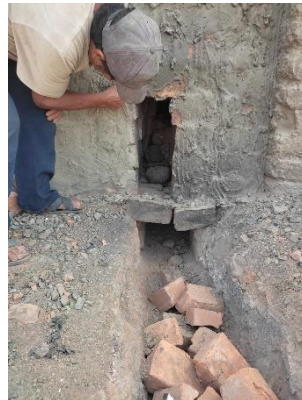
Figura 14. Incineración de las cáscaras de arroz en horno artesanal de una ladrillera
