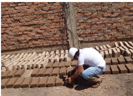
Fotografía 3. Fabricación del adobe
