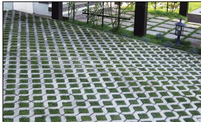
Figura N° 01: Superficie permeable colocada
