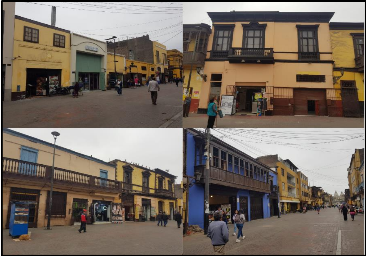
Figura 15: Fachadas de edificaciones históricas que han sido mejoradas por comerciantes (Fuente: propia, 2023)
