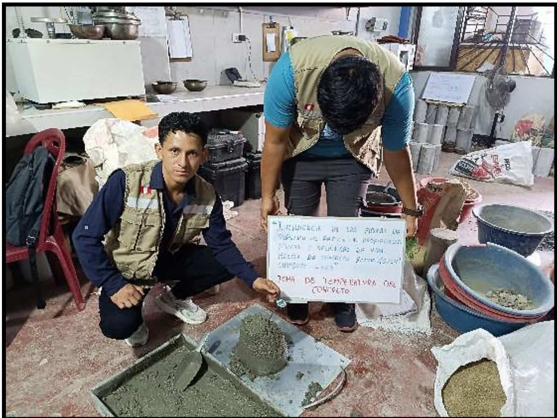
Foto 26: Toma de Temperatura del Concreto
