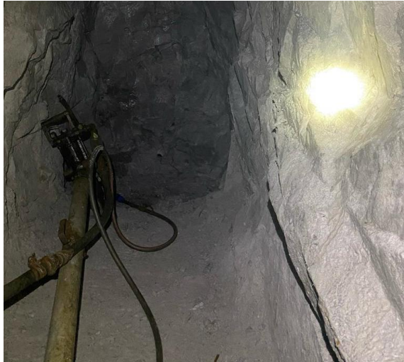
Figura 22. Equipo de perforación
