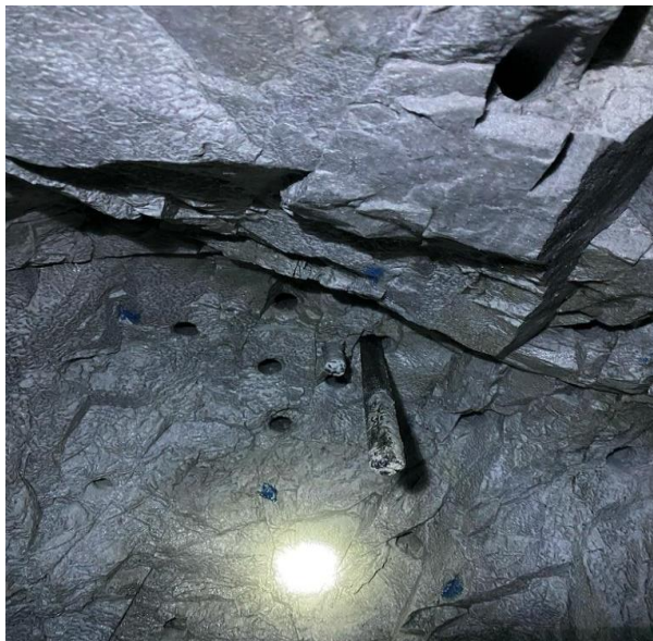
Figura 23. Verificación de guidores para el paralelismo entre taladros
