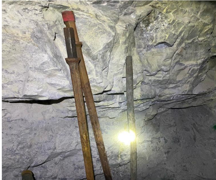
Figura 16. Verificación de estado de los barreros
