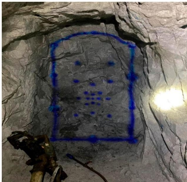
Figura 14. Diseño de malla teórica propuesta Fuente: Elaboración propia
