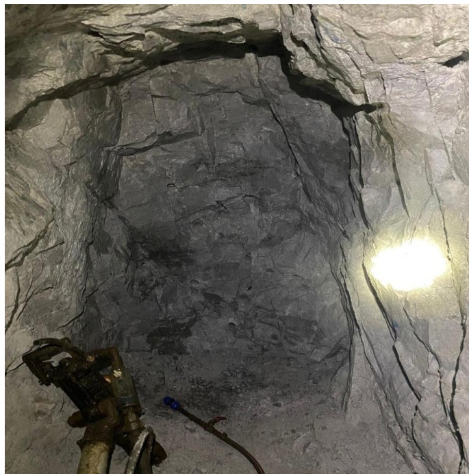
Figura 07. Frente de perforación labor La Muda
