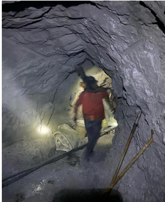
Figura 21. Verificación de la preparación de equipos para la perforación
