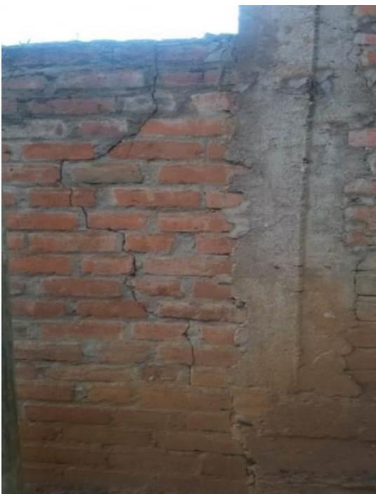
*Figura 1 Muro de ladrillo artesanal con grietas*
