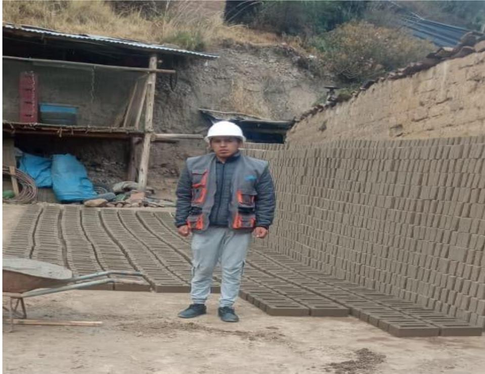
Figura 10. Preparación de ladrillos con adición de ceniza.
