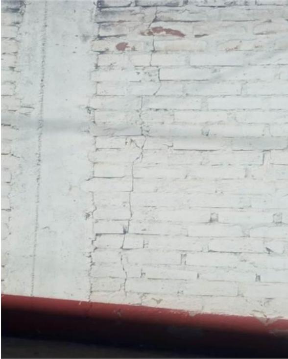
*Figura 2 Vivienda de ladrillo artesanal con fisuras*
