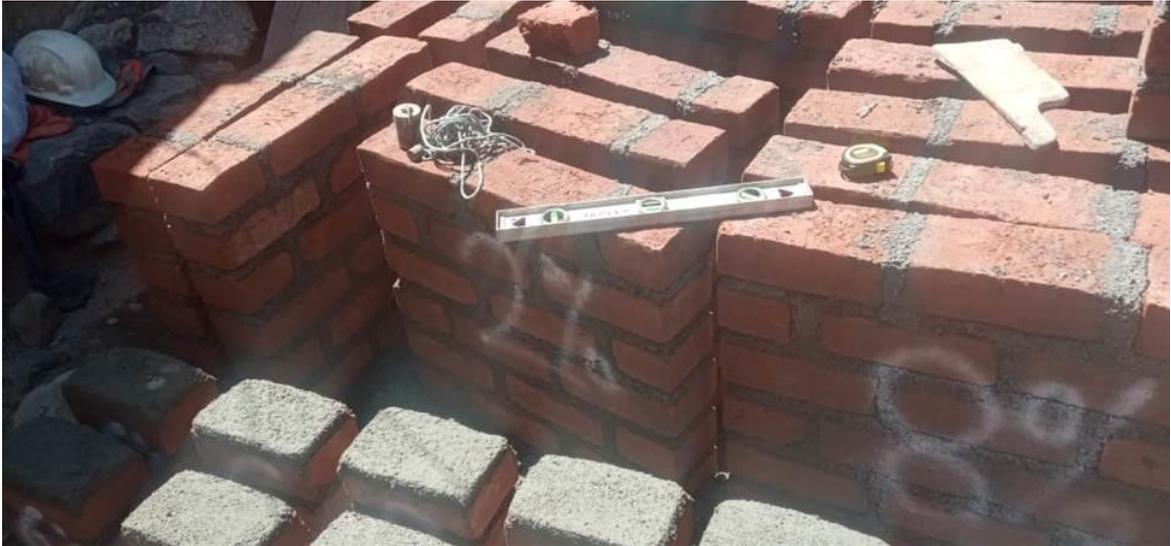
Figura 12. Preparación de muros con ladrillos artesanales.
