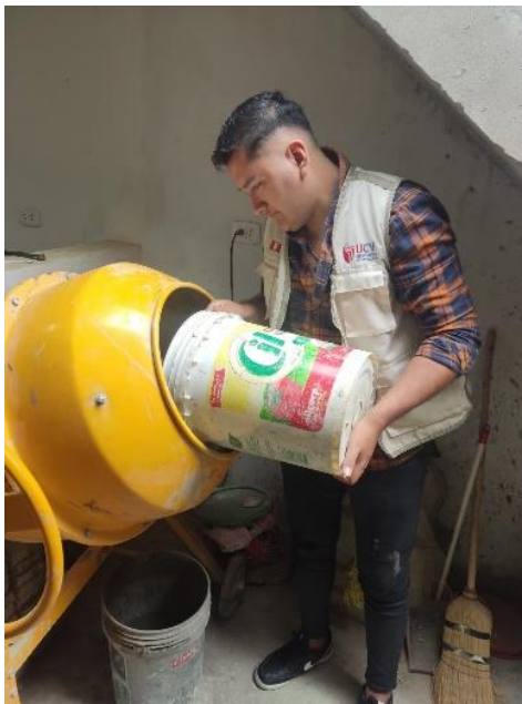
Foto 04. Tesista echando el agregado al trompo para la mezcla de concreto
