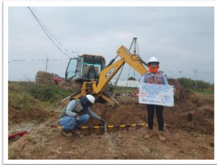
Figura 35: excavación de calicatas con maquinaria pesada a una profundidad de 5 m.
