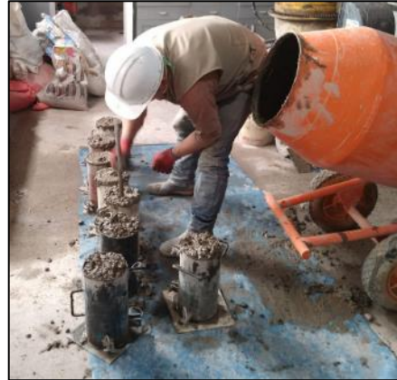
FIGURA 30: Varillado de probetas cilíndricas
