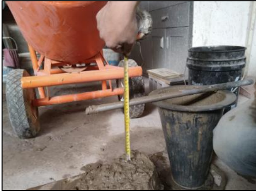
FIGURA 23: Ensayo de trabajabilidad del concreto
