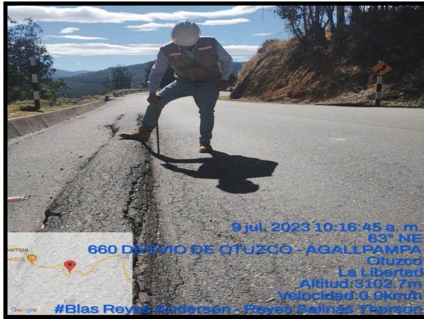
Fotografía 3: Se observa la medición de la falla Hundimiento donde la profundidad es de 10 centímetros donde nos indica que el pavimento tiene una base indeficiente.
