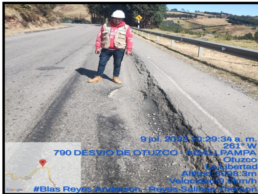
Fotografía 3: Se observa la medición de la falla Hundimiento donde la profundidad es de 10 centímetros donde nos indica que el pavimento tiene una base indeficiente.
