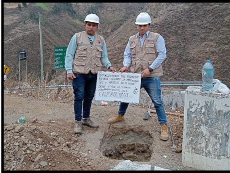
Fotografía 5: Se observa la excavación de las calicatas de manera manual en la cual nos permite observar de manera directa el terreno, y la toma de muestras para posteriormente la realización de los ensayos en el laboratorio.
