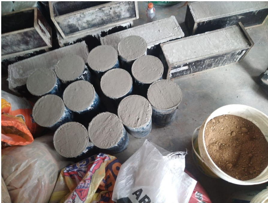
Figura 11. Vaciado de concreto a las muestras de probetas
