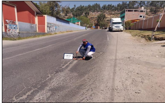
Imagen 10. Falla tipo Desplazamiento
