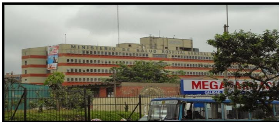
Figura 52. Hospital María Auxiliadora sector 4 Fuente: Google Maps
