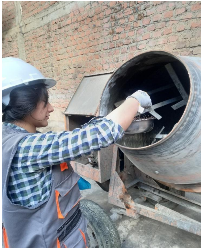
Figuras. N° 25: Adición de fibra de acero de 6kg a la mezcla de concreto
