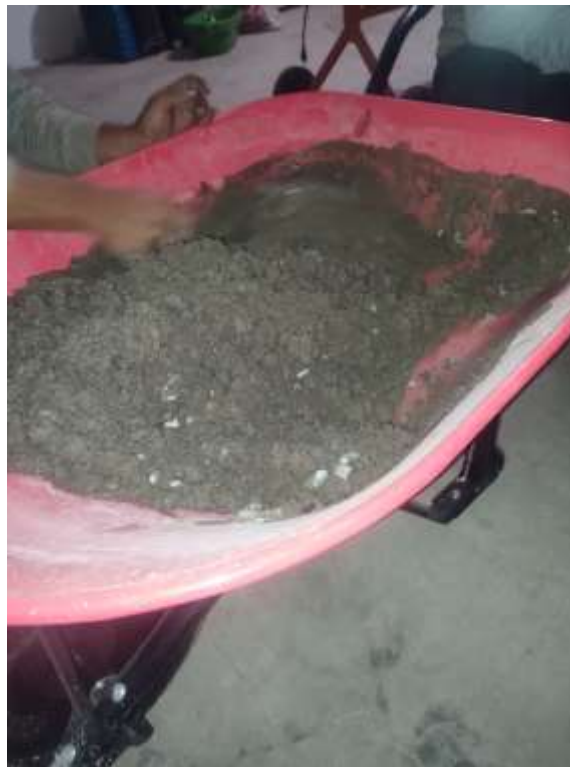
Imagen 15: Mezcla de concreto fresco.
