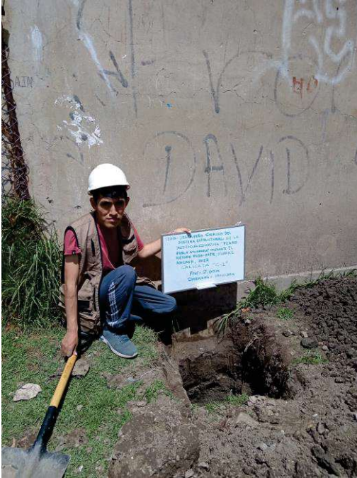
Foto 01: Calicata de 1.50 x 1.50 x 2.00m
