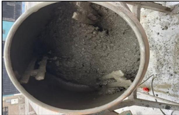
**Figura 14:** Dosificación del concreto  $f'c$ :210.
