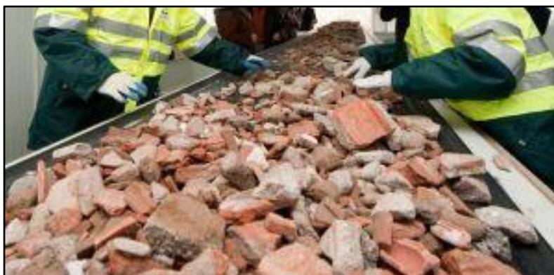
*Figura 01: Residuos de construcción y demolición*
