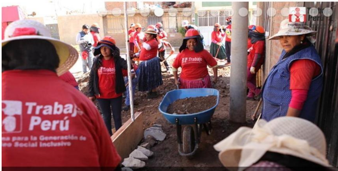
Foto 1. Mujeres participantes del programa en trabajos de albañilería
