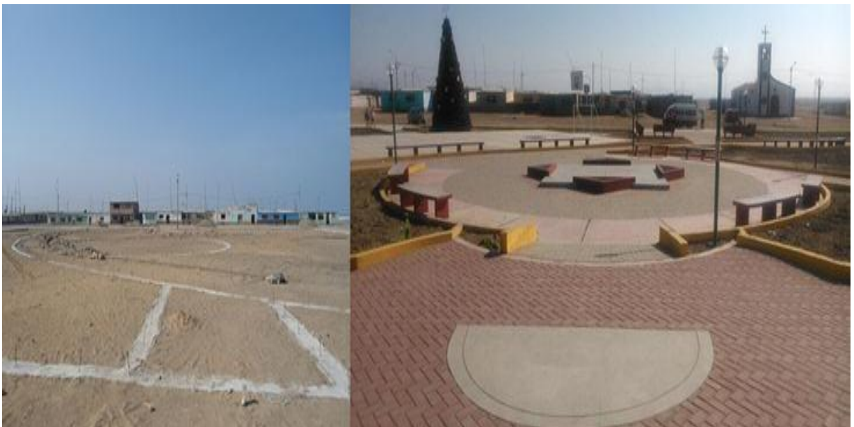
Foto 6. Construcción de Parques y áreas verdes.
