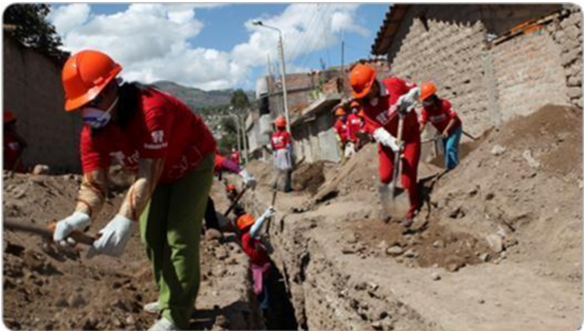
Foto 2. Mujeres participantes del programa en construcción de muros de contención
