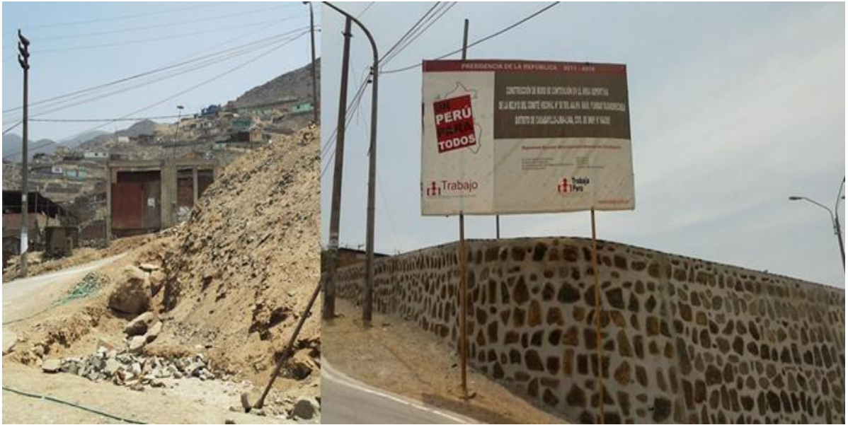
Foto 5. Construcción de Muros de Contención
