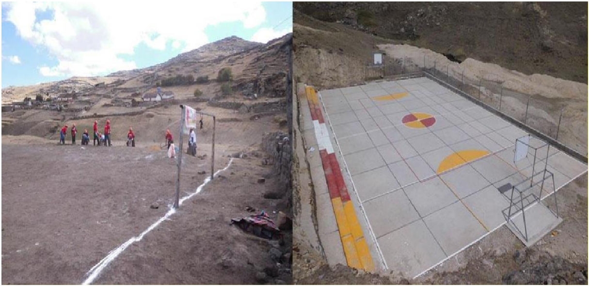
Foto 3. Vista antes y después construcción de losas deportiva
