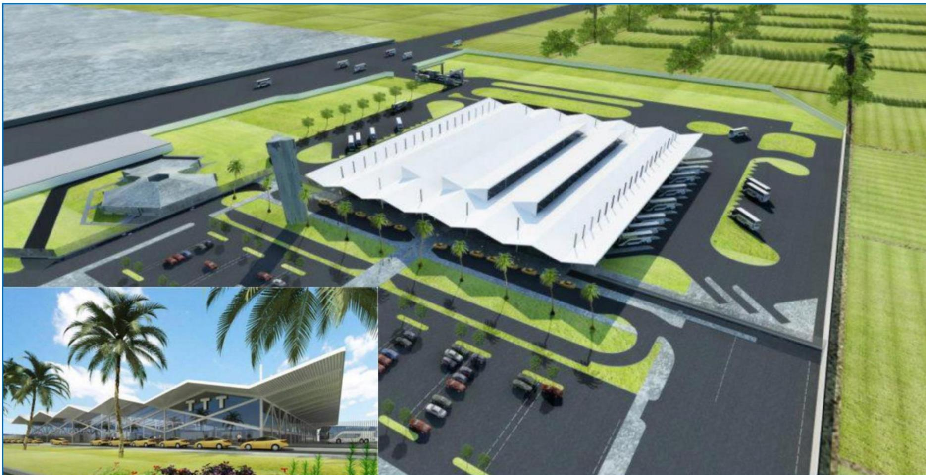
*Nota:* Terminal terrestre de Trujillo, ubicado a márgenes de la Panamericana norte, compone una arquitectura moderna mediante la aplicación de estructuras metálicas, destaca la formación de estructuras diagonales ligeras tipo Diagrid en el contorno del edificio.
