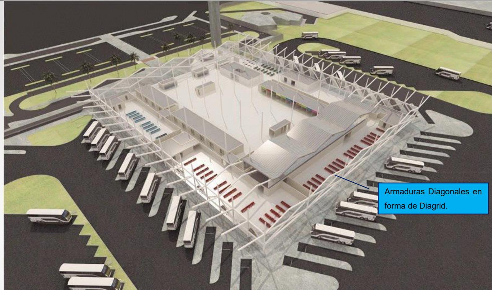
Armaduras Diagonales en forma de Diagrid.
