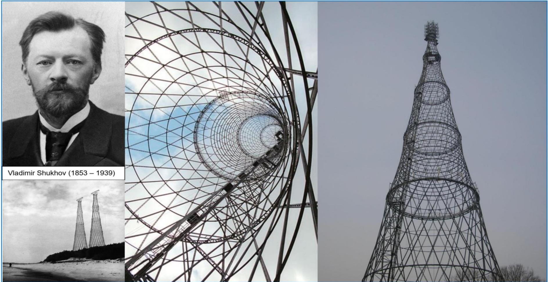
*Nota.* Vladimir Shukhov; (Vista de la torre cónica de Shukhov, ensamblado por retículas romboidales a base de elementos de acero).
