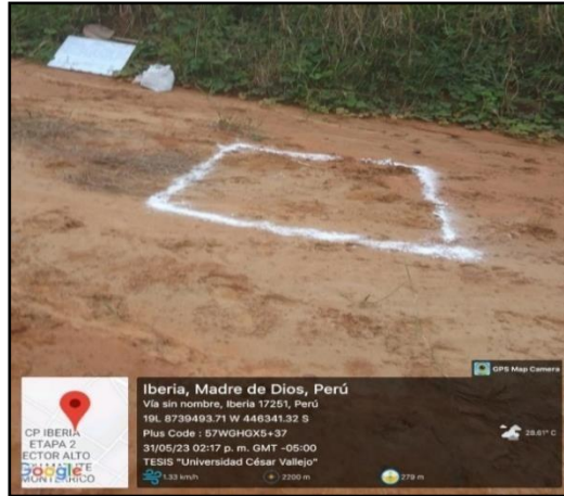
Figura 7 Demarcación de área a excavar
