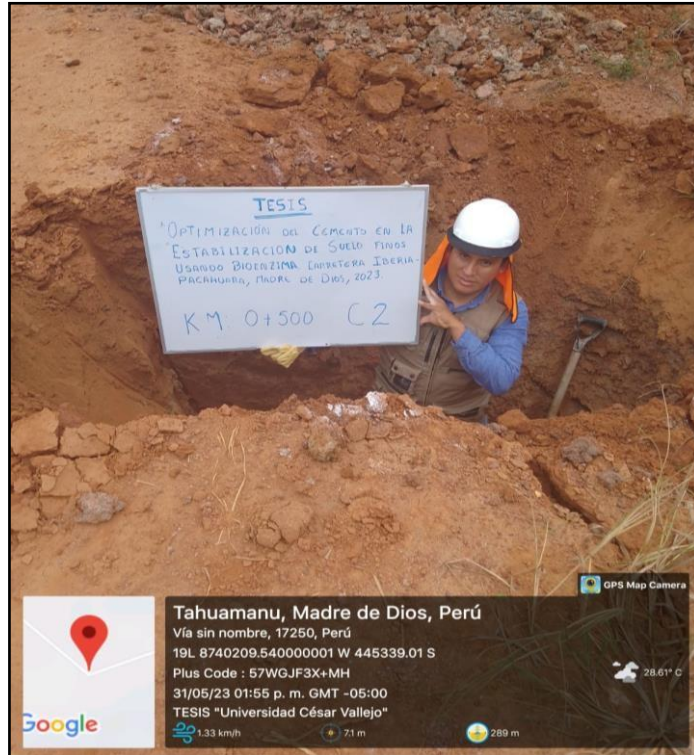
Figura 30 Excavación y toma de muestra C -2
