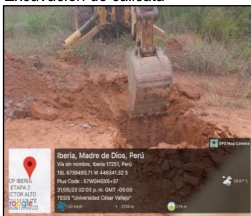
Figura 6 Excavación de calicata
