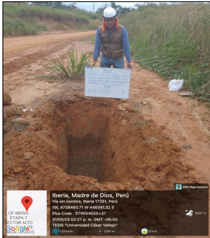
Figura 31 Excavación y toma de muestra C - 3
