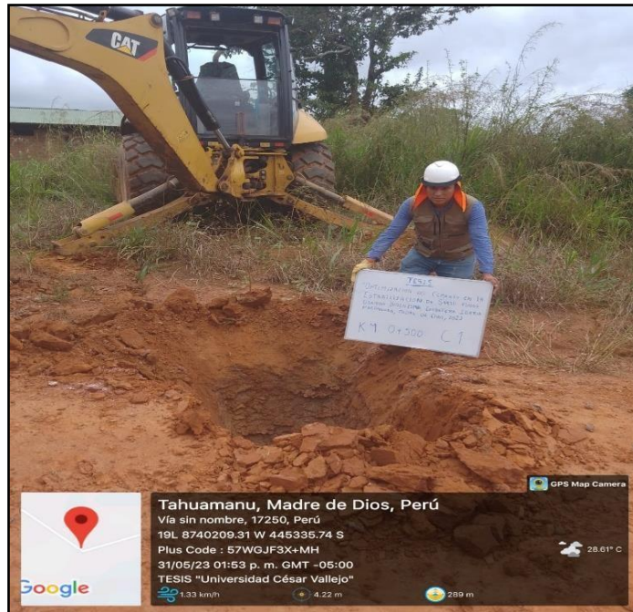
Figura 29 Excavación de calicata con maquinaria pesada
