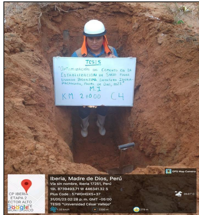
Figura 32 Excavación y toma de muestra C - 4
