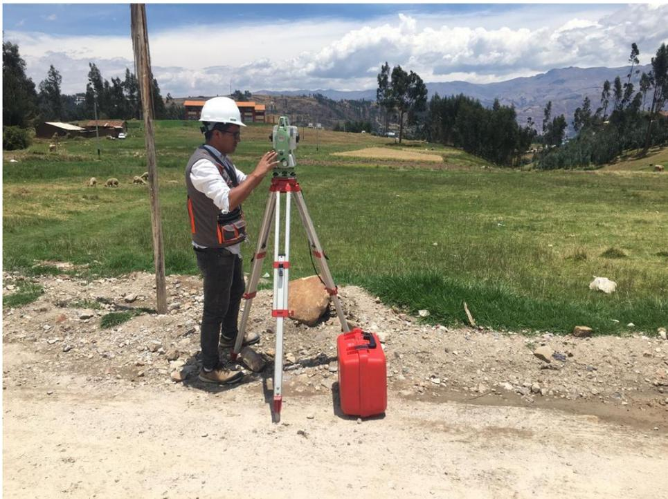
*FOTOGRAFIA 5: Levantamiento topográfico en el sector caras-chico*
