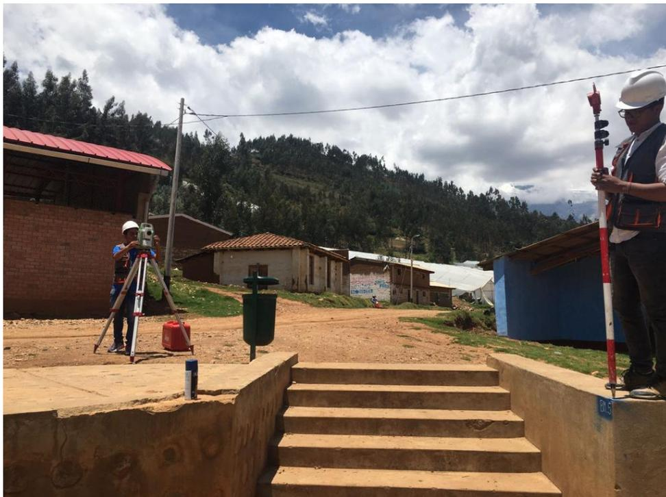
*FOTOGRAFIA 7: Puntos del BM en la localidad de Cochapampa*
