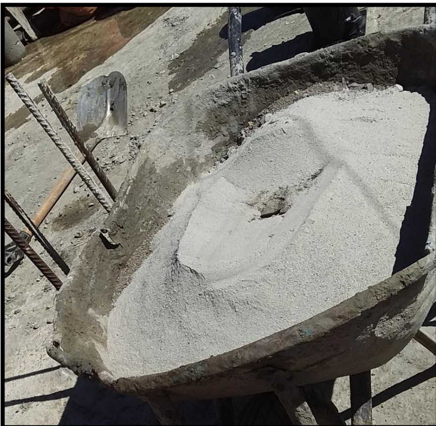
Fotografía N° 14: Elaboración de la mezcla de concreto con sustitución del agregado fino por relave minero.
