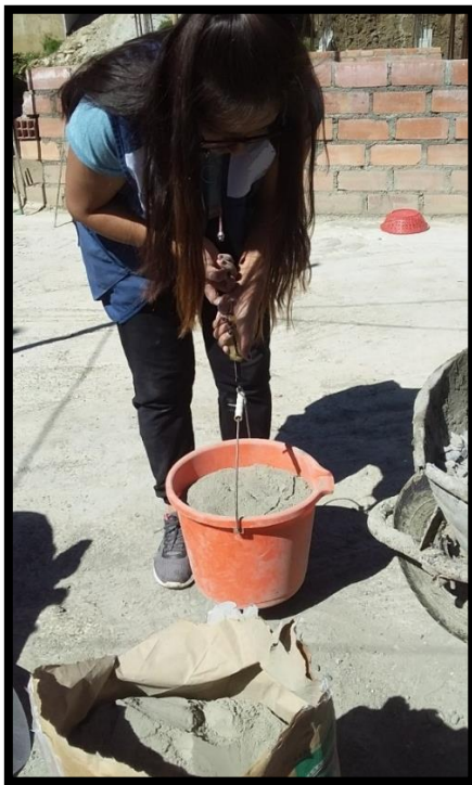
Fotografía N° 12: Pesado del cemento portland Tipo I para la elaboración de la mezcla de concreto.
