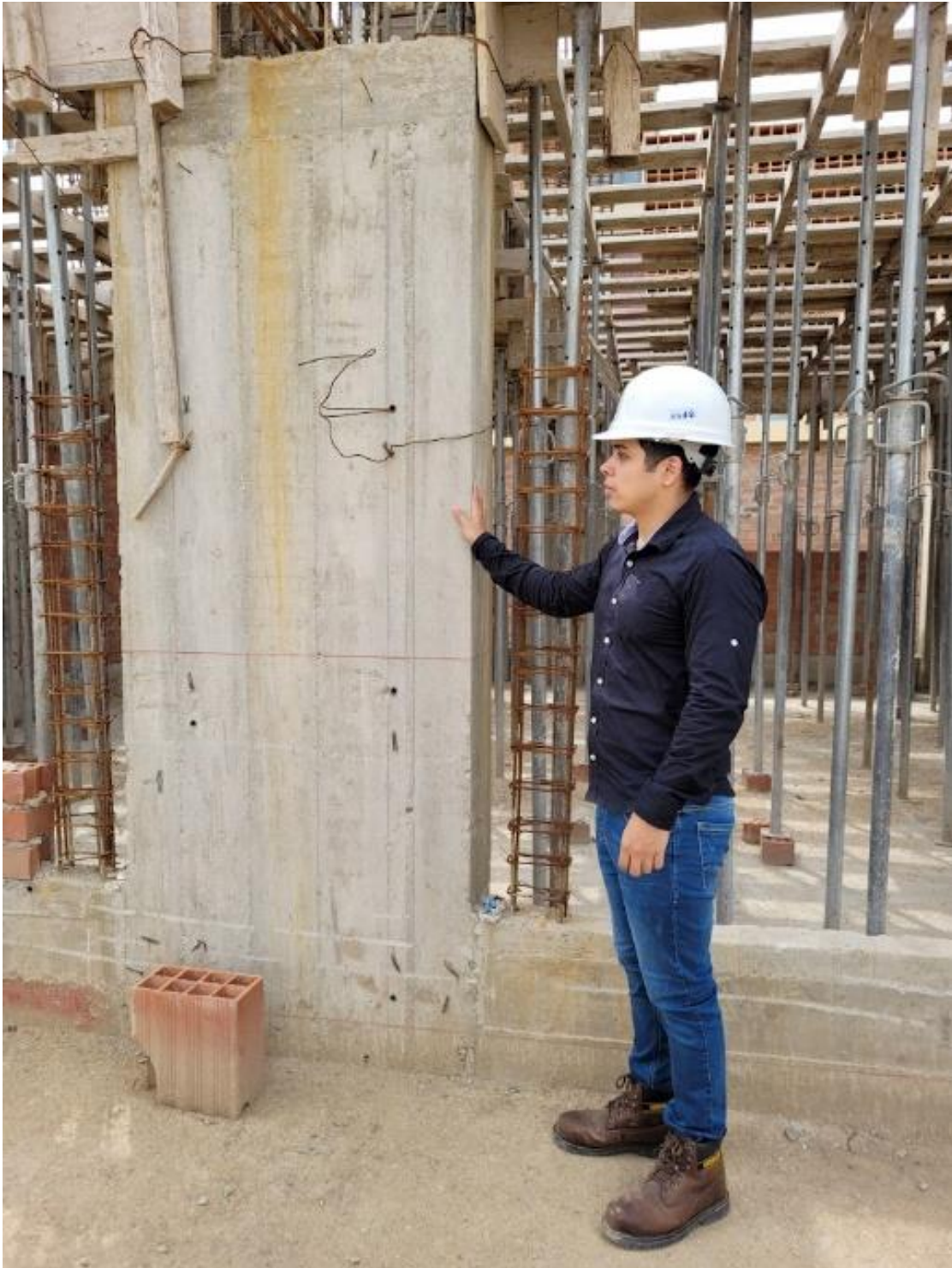
Fotografía 8.4: de levantamiento de columnas de primer nivel
