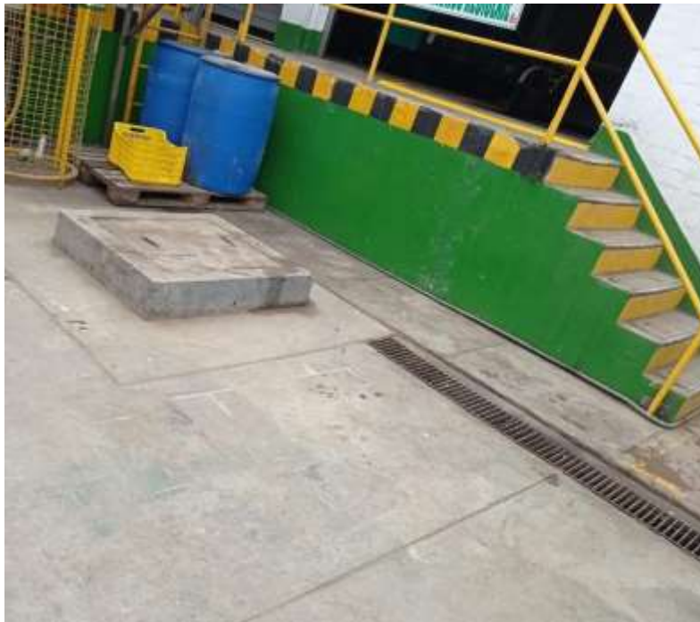
Anexo 131. Exteriores del taller de mantenimiento después del proceso de limpieza.
