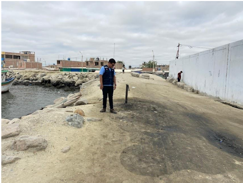
Observación del estado actual de la caleta de Parachique.
