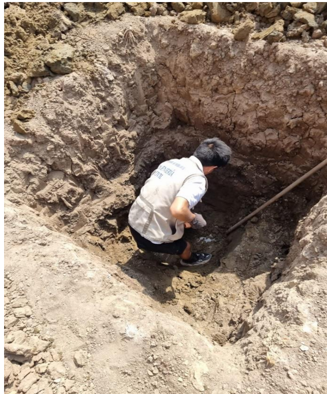
Figura 30: Excavación de las calicatas
