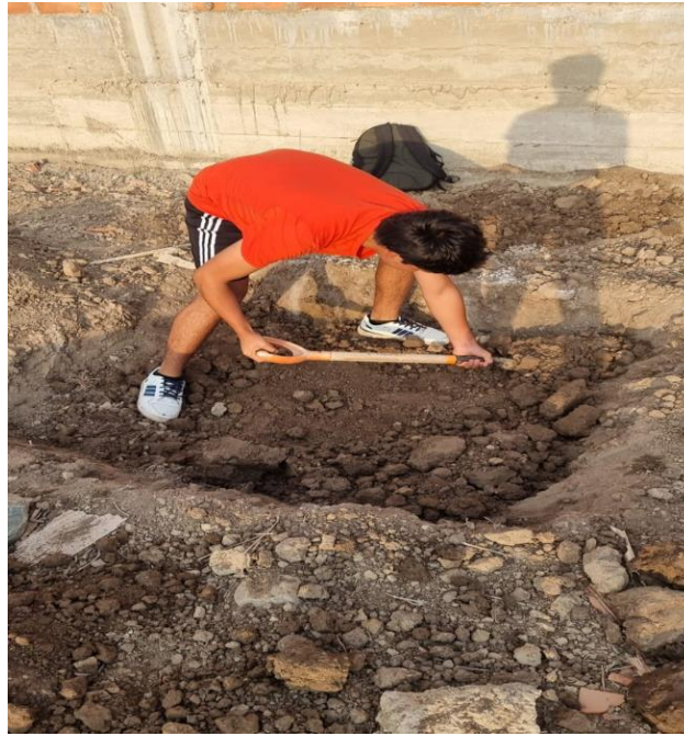
Figura 29: Excavación de las calicatas
