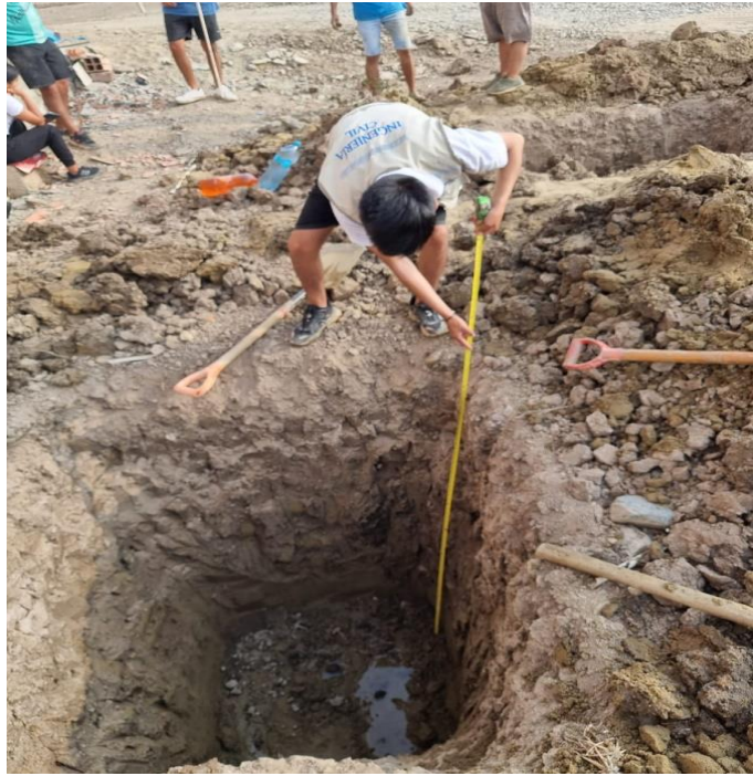
Figura 31: Midiendo la altura de una de las calicatas de 1.70m.
