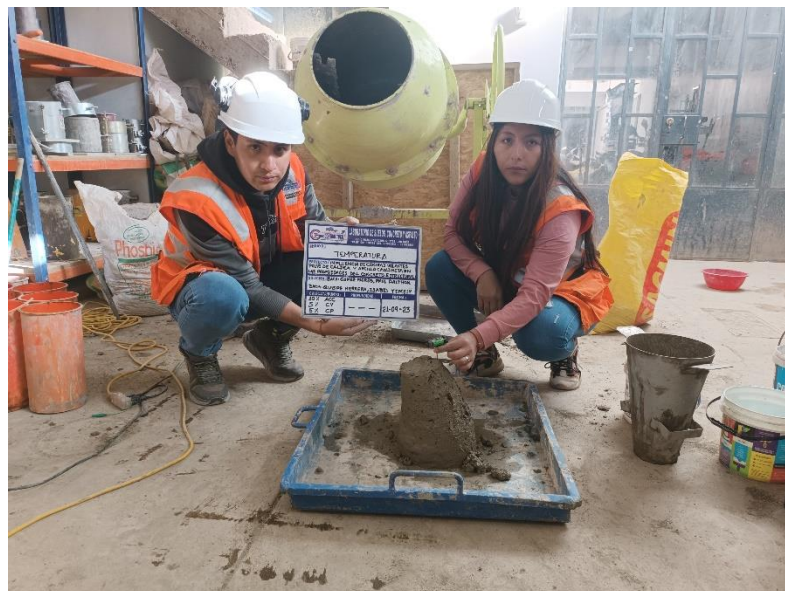
Figura 41. Prueba de temperatura del concreto.
